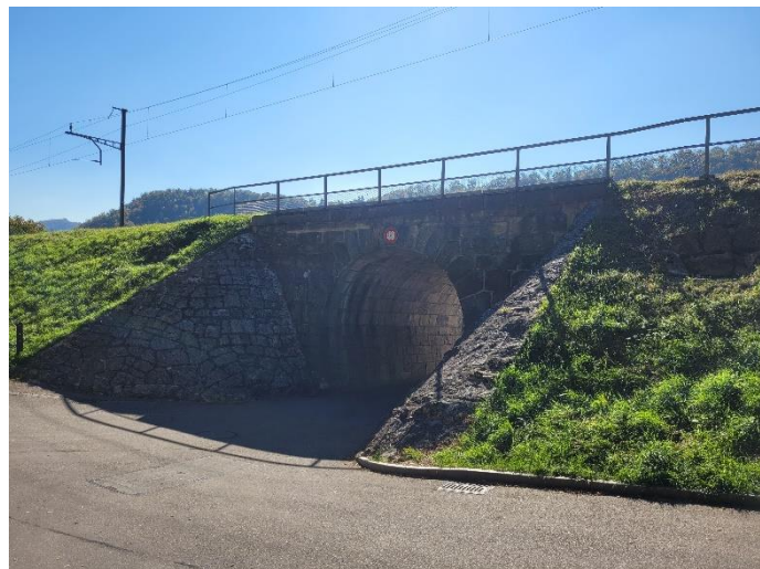
Abbildung 6: Hennebüelweg Unterführung Milchgasse
