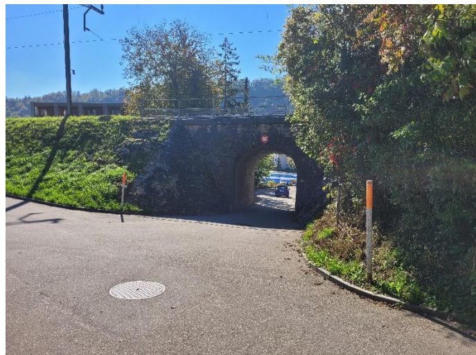
Abbildung 4: Hennebüelweg Unterführung Brüelmattstrasse
